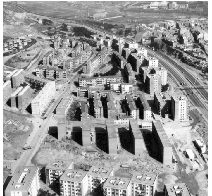
El polígon residencial de Trinitat Nova de Barcelona, 1953-1963. Patronat Municipal de l'Habitatge de Barcelona.
